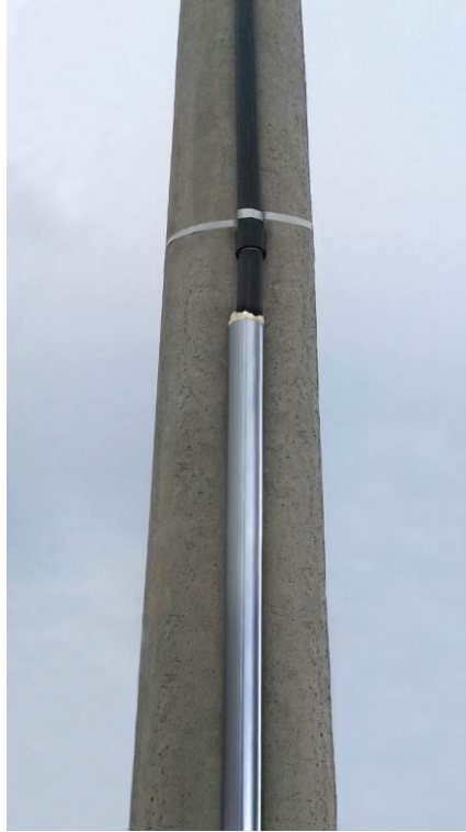
Foto ilustrativa 01 dos anexos W, Y, AA, BB, CC, DD e EE – Detalhe do eletroduto junto ao poste
