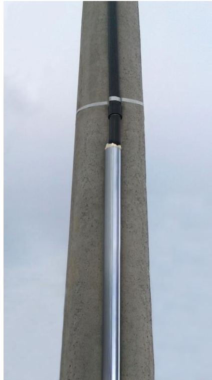
Foto ilustrativa 01 dos anexos G, H e Q – Detalhe do eletroduto junto ao poste
