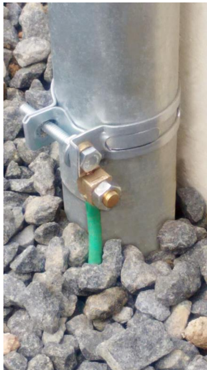
Foto ilustrativa 02 dos anexos G, H e Q – Detalhe da abraçadeira de com terminal para aterramento
