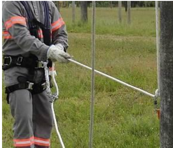
Figura 40 – Acionamento do nó de freio
