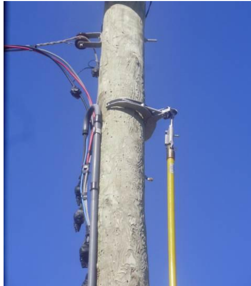
Figura 27 – Ancoragem da garra
