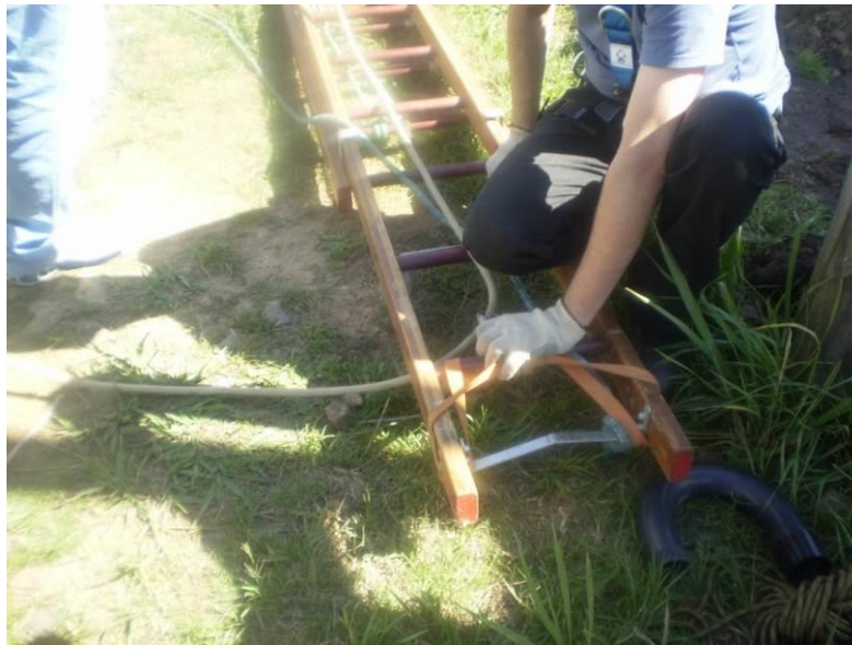
Figura 13 – Instalação da linha de vida
