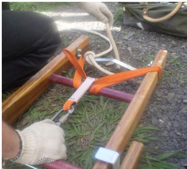
Figura 12 – Instalação do ponto de ancoragem
