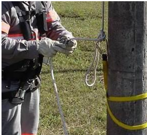
Figura 39 – Instalação do trava-quedas
