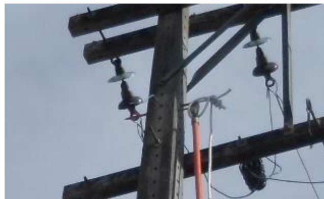
Figura 31 – Instalação do agulhão no poste
