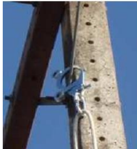
Figura 30 – Instalação do gancho na estrutura metálica do poste
