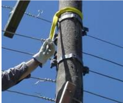
Figura 16 – Ancoragem com fita e mosquetão no poste
